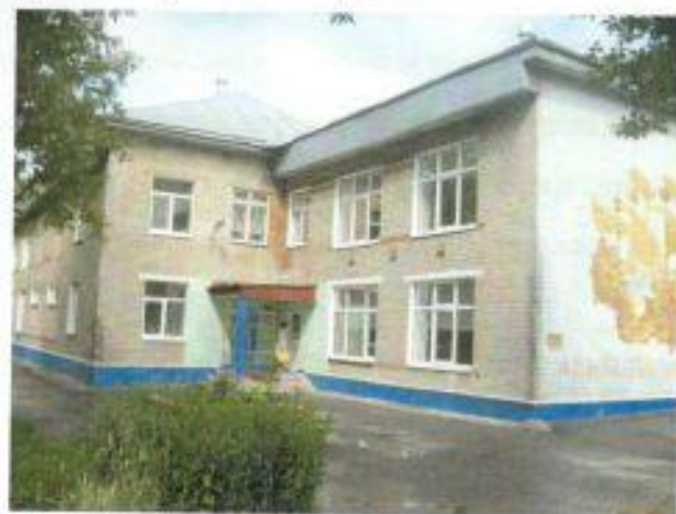
Рис. 1 Общий вид здания
